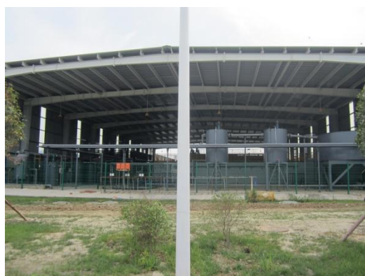
兵装园区污水处理站
