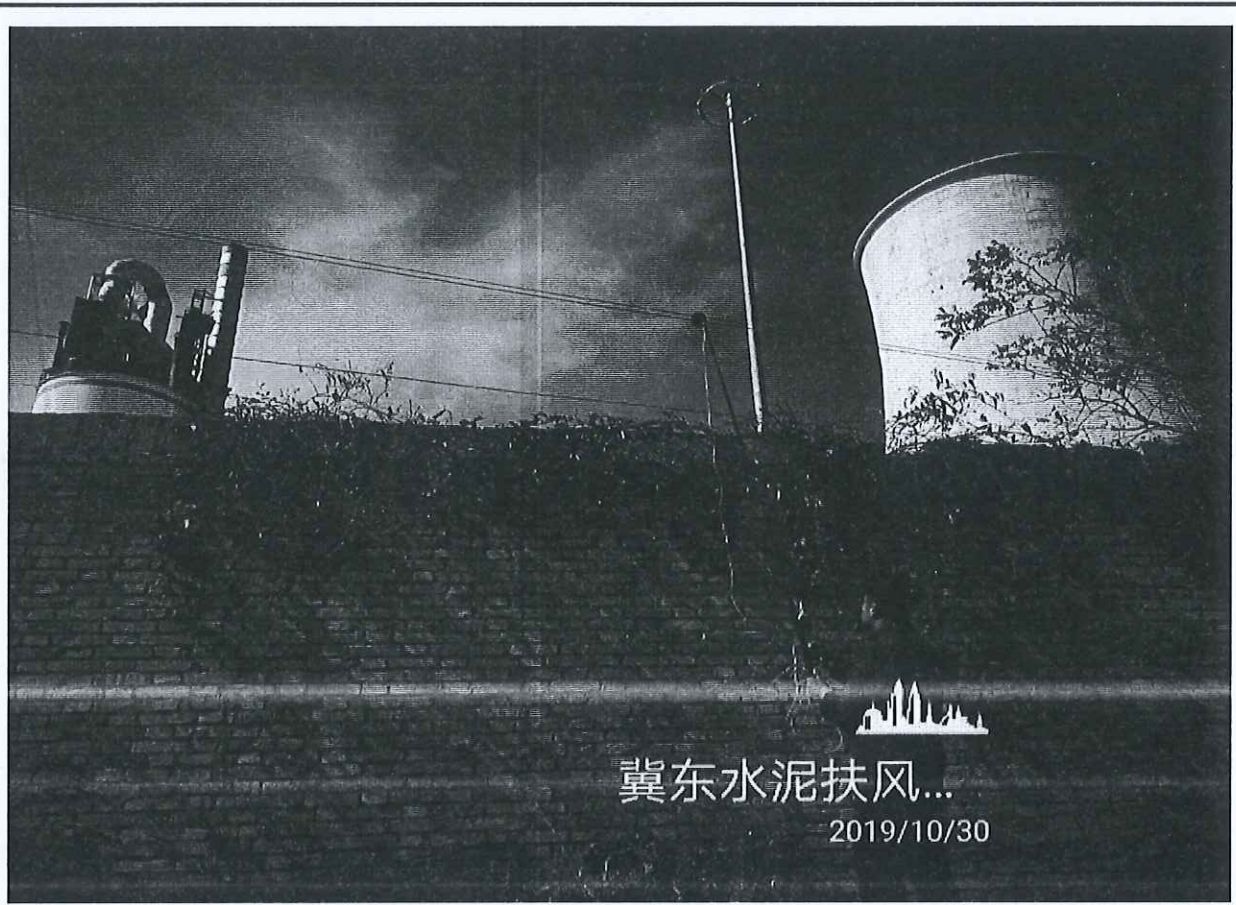
附件：现场监测照片
