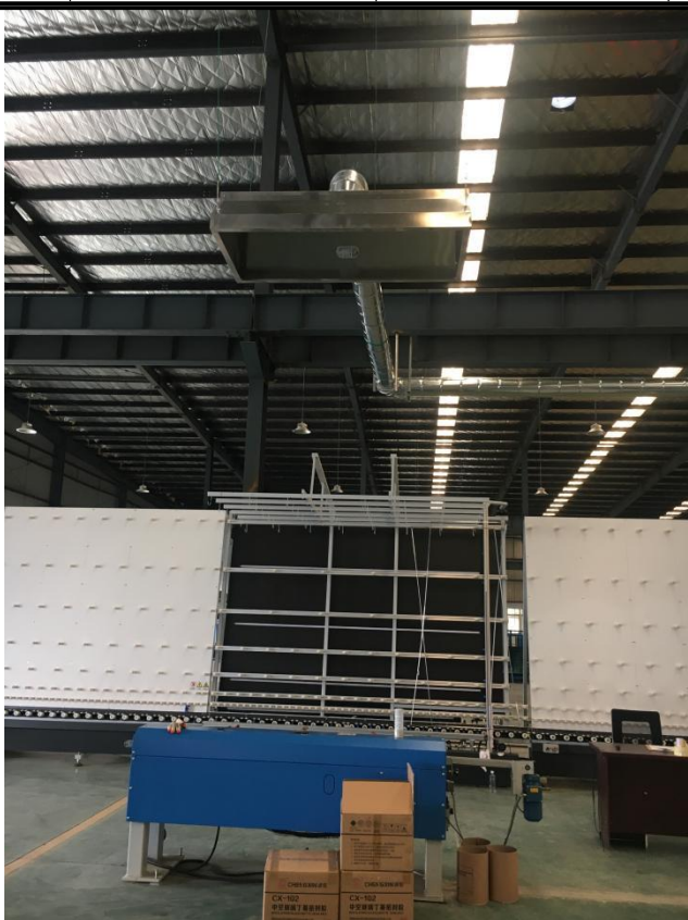
丁基胶集气管道布管现状
