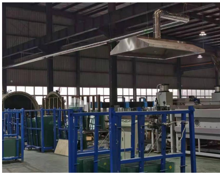
压片工序集气管道布管现状
