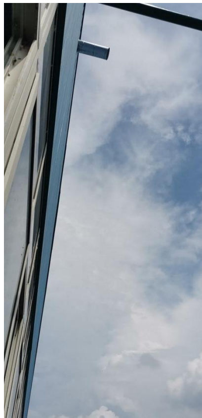
活性炭吸附装置排气筒 (FQ1)
